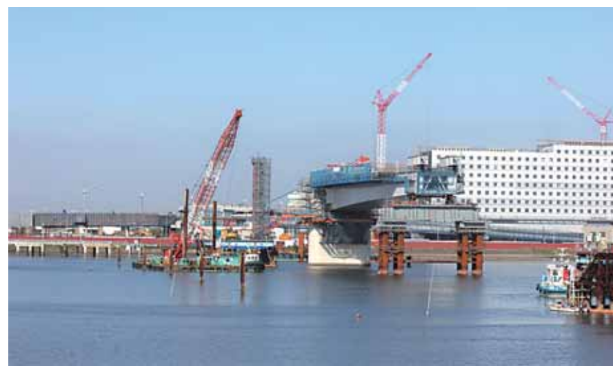
20年度完成に向け工事が進む羽田空港とキングスカイフロントを結ぶ連絡橋。人材や技術の国際交流が加速する
